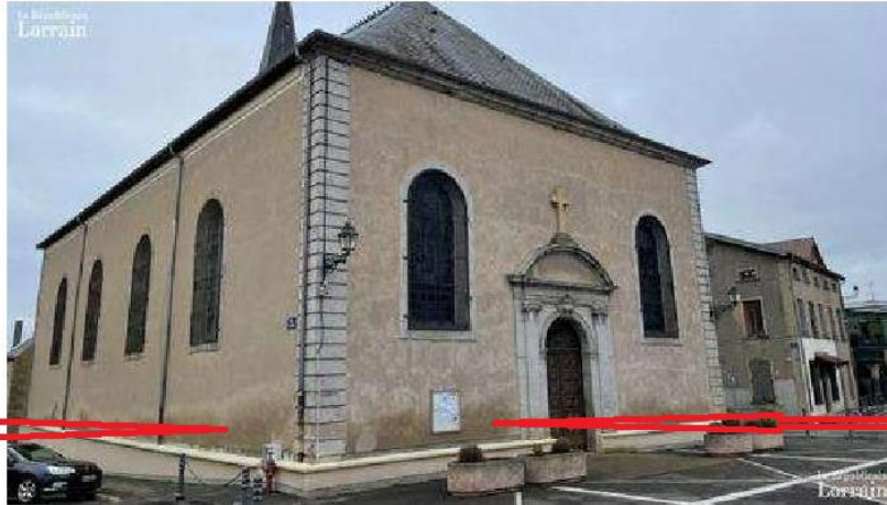
L'église Saint-Vincent, à Faulquemont, est fermée. Un appel aux dons est lancé pour sauvegarder l'édifice religieux.
