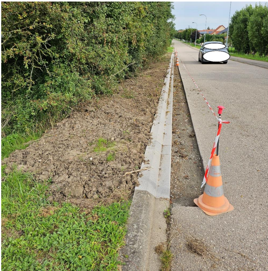
Photo rue Saint-Vincent
