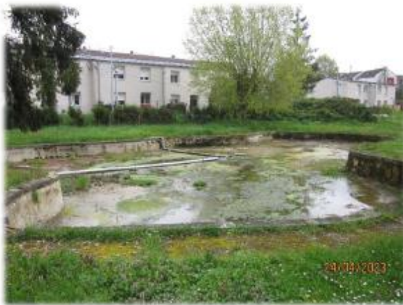
Vue du bassin vidangé
