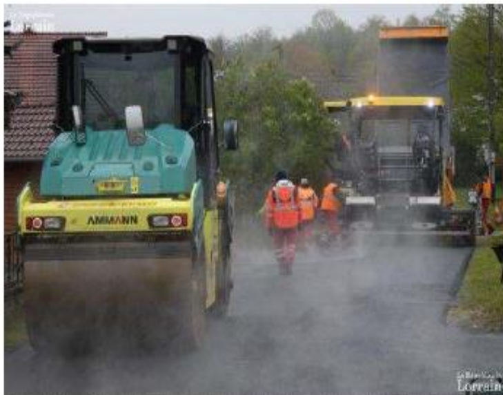
Deux ronds-points de l'axe central de Faulquemont vont être en travaux, ainsi qu'un tronçon du contournement. Photo d'illustration FR
