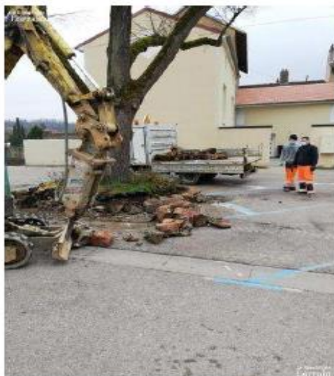
Une partie du square Schuman a été fermée aux automobilistes jeudi 25 et vendredi 26 février pour permettre aux employés communaux d'entreprendre les travaux au niveau de l'arbre. Photo RN / MétéoMédia CNA RTTF
