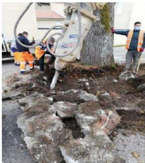
L'entreprise Recker, qui opère des travaux sur le réseau d'eau et d'égouts, a prêté main forte aux employés communaux pour réaliser le hélicon qui déboulait les racines du tilleul. Photo RN / MétéoMédia CNA RTTF
